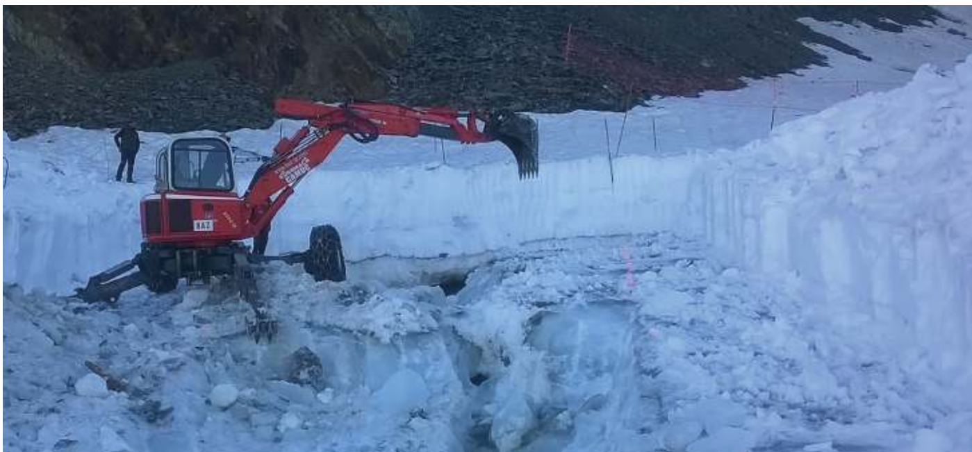
Creusement de la crevasse existante, la seule, rive droite, afin de faciliter la sortie de l'eau et d'abaisser la pression existante dans la cavité ; rappelons la situation particulière de ce glacier qui ne dispose pas d'exutoire, et pire, dont le manteau de surface est en glace tempérée, laquelle laisse l'eau percoler et remplir une cavité qui est formée par le front glacière, qui lui est en glace froide - © ONF/RTM 74
