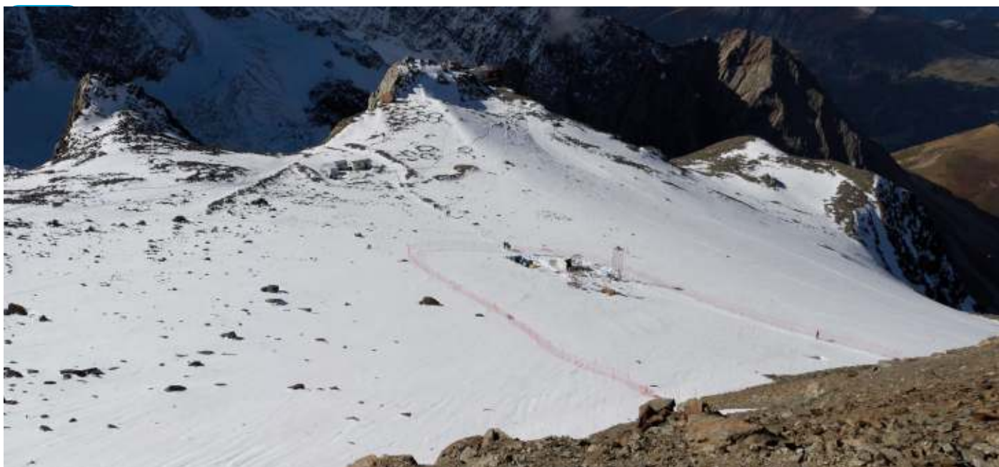
Les travaux qui ont pu être faits : pompage les premières années, avec l'installation de pompage et la base vie - © ONF/RTM 74
